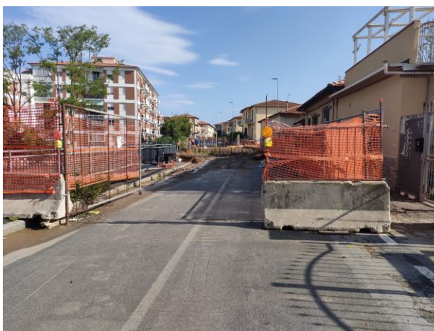
Il Cantiere di lavoro per il Ponte in Via di Salviano
